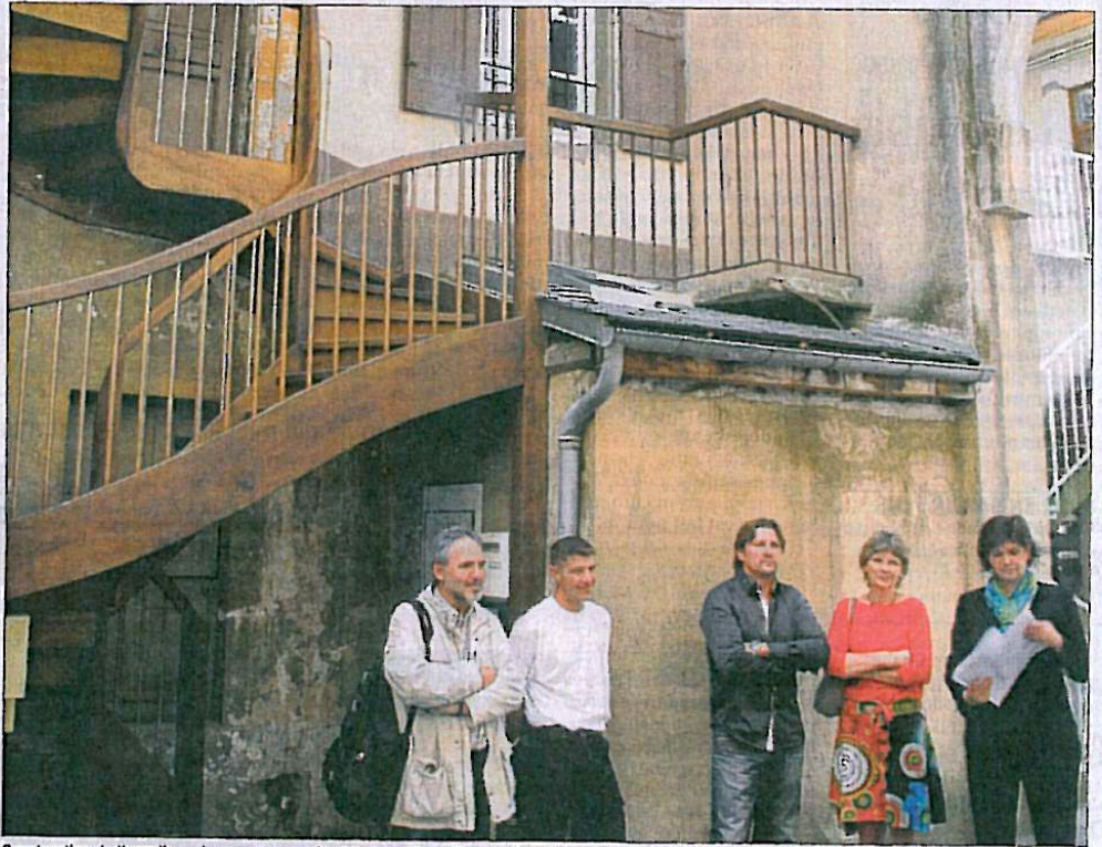
Construction de l'escalier, mise aux normes électriques... Lors d'une visite officielle, les élus prennent acte de la première concrétisation de l'OPAH au 141 rue Dessaix. Photo Le DL
